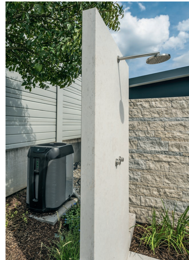
Der stelenartige Korpus der Gartendusche schirmt die Wärmepumpe optisch und akustisch ab.
