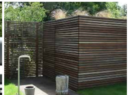
Schicker Blickfang mit Funktion: Eigens für die Installation der Schwimmbadtechnik ließen die Bauherren diesen mit Stäben aus Bangkirai-Holz verkleideten Kubus errichten.
