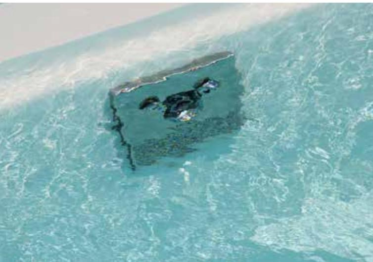
**Die uwe-Gegenstromanlage „Juno“ erzeugt eine starke Strömung im Becken und gewährleistet so ein ausdauerndes Schwimmtraining.**
